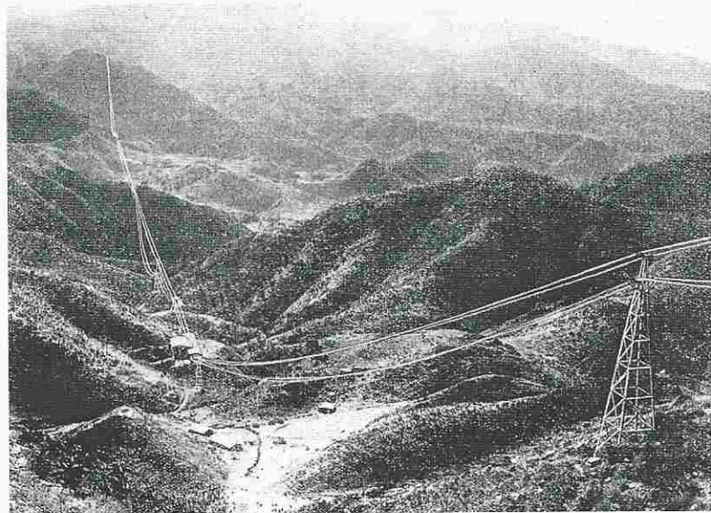
I due tronconi della teleferica Asmara-Massau verso la Stazione di Galci e il Monte Abeganziè
