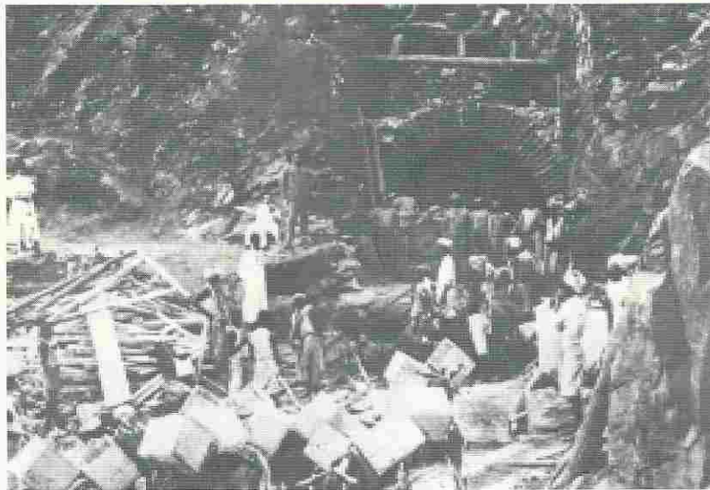
1909 - Massaua-Asmara, costruzione galleria ferroviaria.
