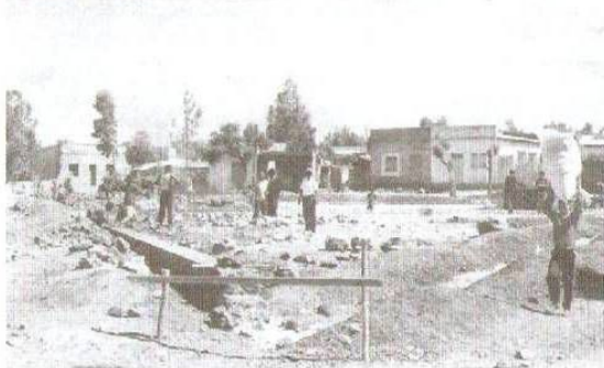
Il Centro di Adi Quala in costruzione
