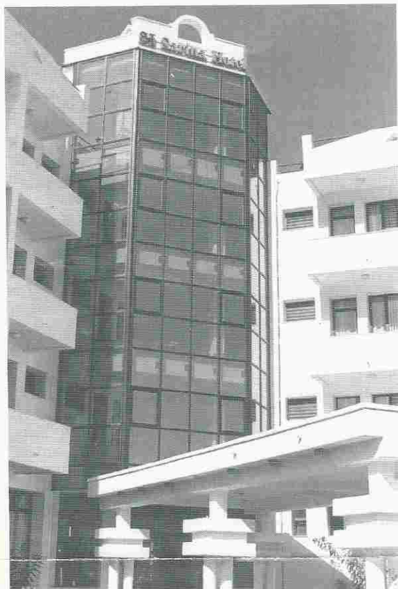
La facciata del nuovissimo albergo costruito a Cheren.
