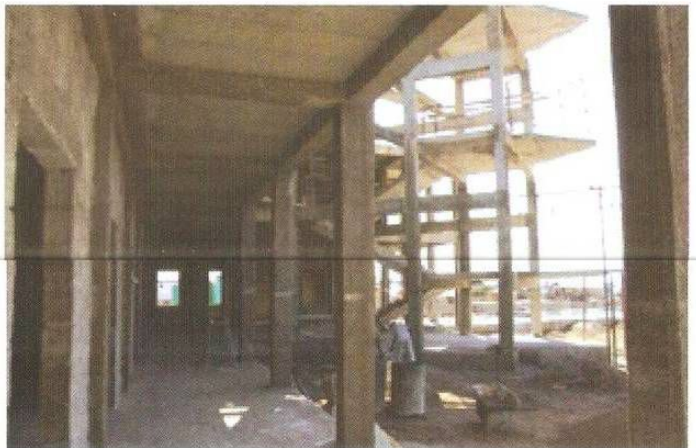
Corridoio e rampa scale.
