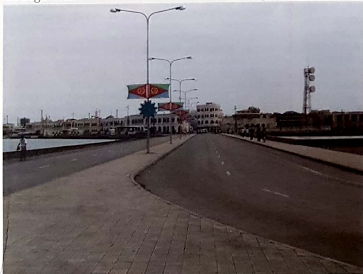
Nella foto si vede l'ultimo dei due tronconi stradali che sono stati allargati e che collegano la terraferma all'isola di Taulud.
