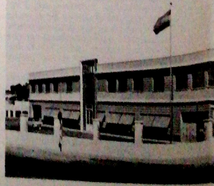
Una più recente veduta dello Stabilimento Fenili
