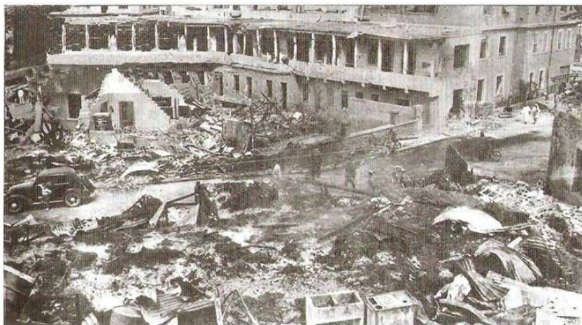
Asmara 23 marzo 1941 - Conseguenze del bombardamento avvenuto nel centro della città. Qui in via Sacconi.
